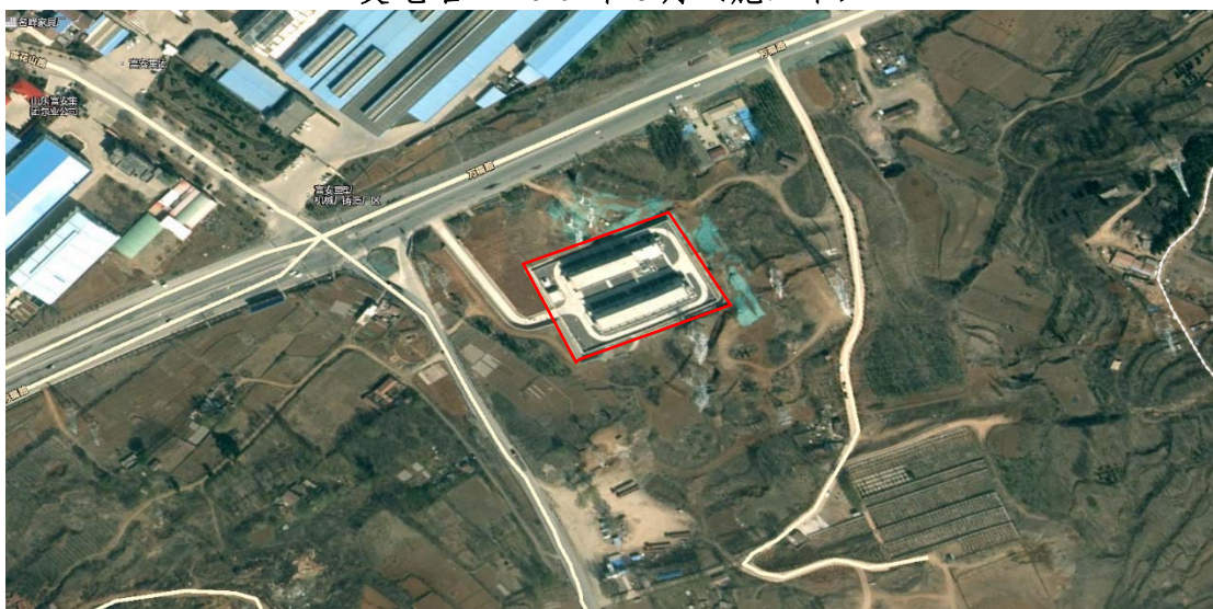
变电站---2020 年 4 月（施工后）
