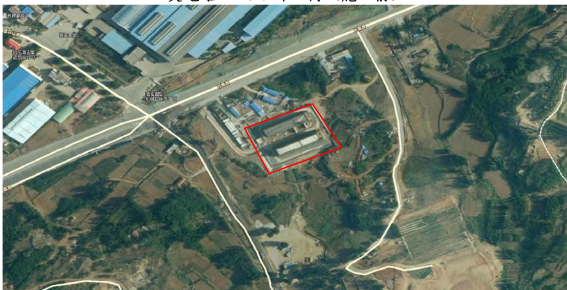
变电站---2019 年 6 月（施工中）
