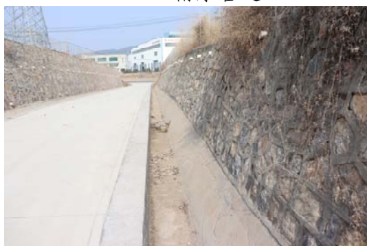
进站道路及排水沟
