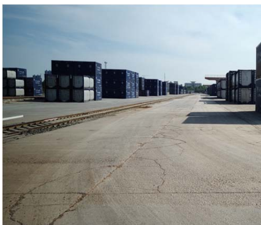
新建铁路北侧地面硬化
