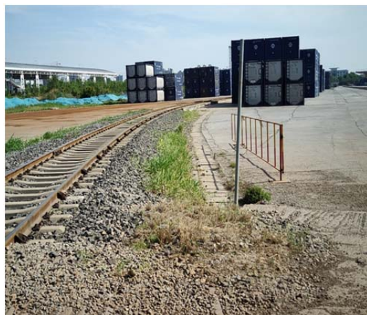
东侧铁路专用线改造
