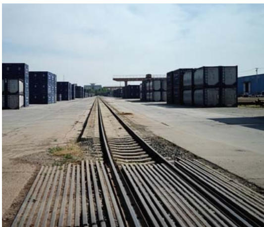
新建铁路专用线
