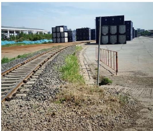
东侧铁路专用线改造
